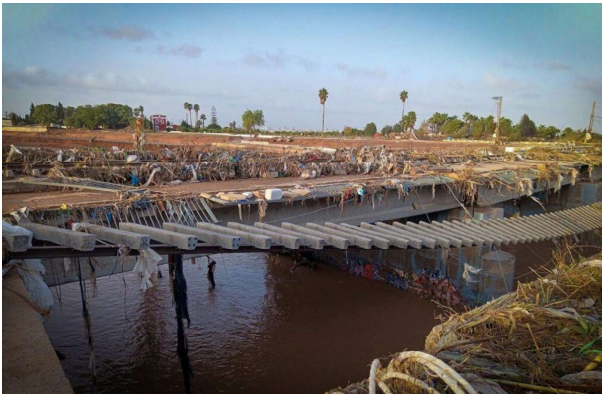
Figura 10: Puente CV-403 de acceso a Alaquàs
