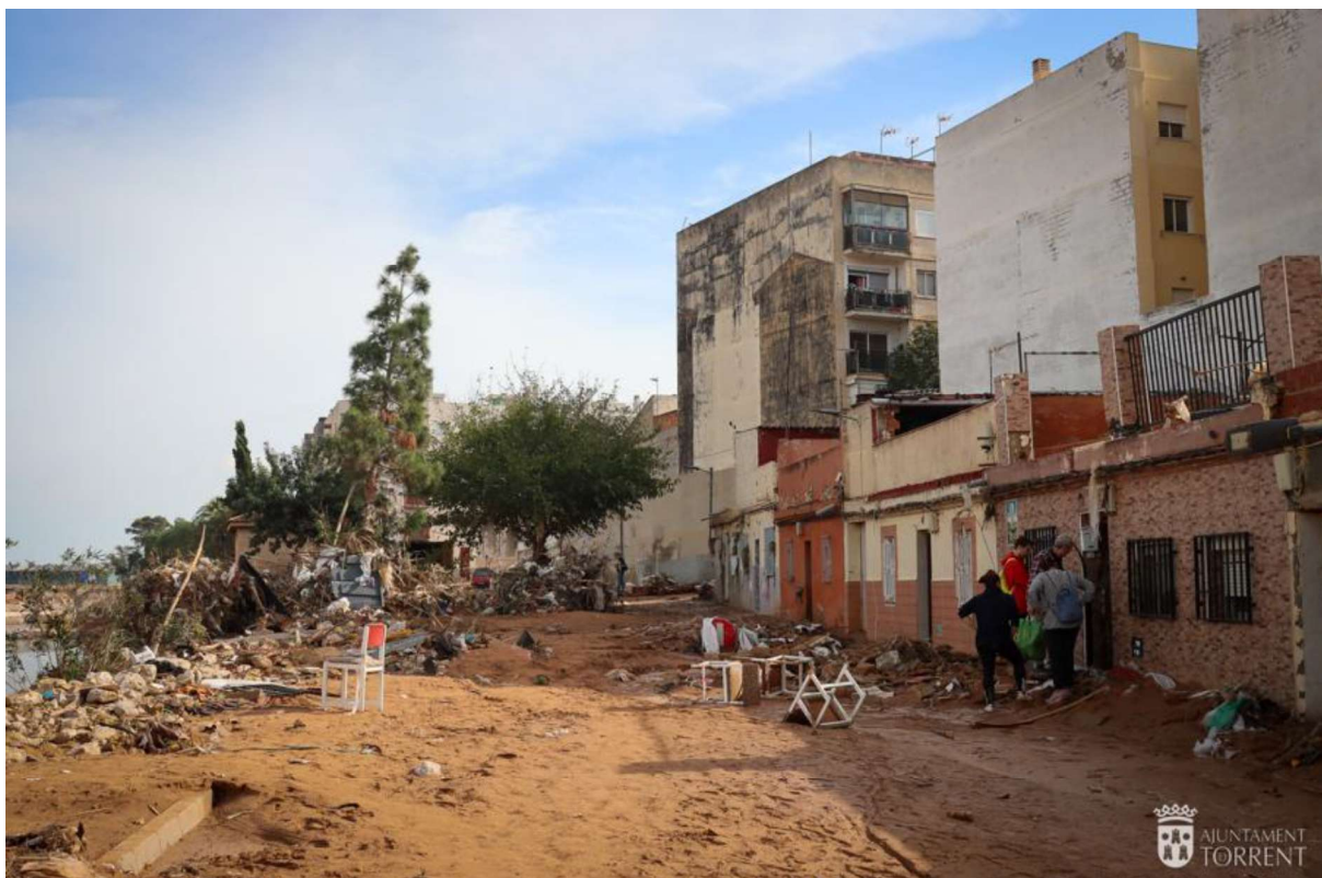
Figura 13: Viviendas en Torrent tras la DANA
