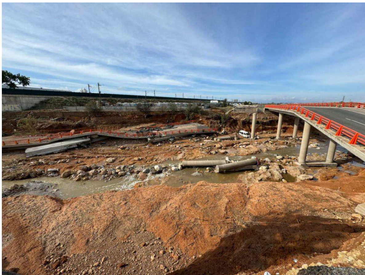
Figura 7: Pasarela acceso peatonal al Barranco
