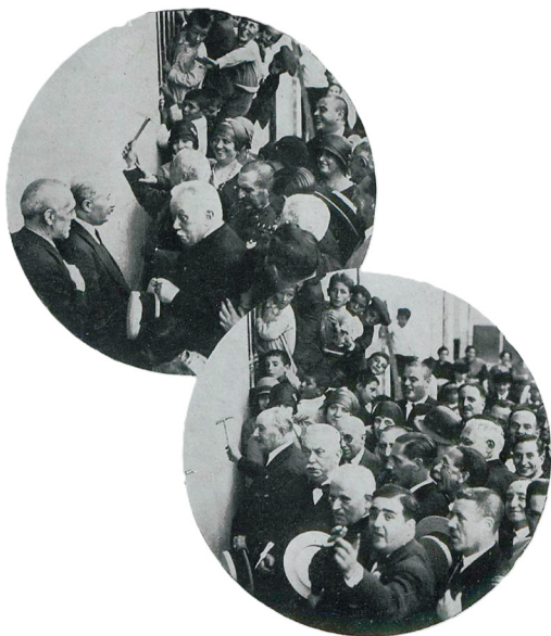
El marqués de Sotelo, arriba, y Hernández Malillos, abajo, con un martillo en la mano, inaugurando las obras que daban comienzo a la apertura de la avenida (Semana Gráfica, 5 de octubre de 1929, núm. 169).
