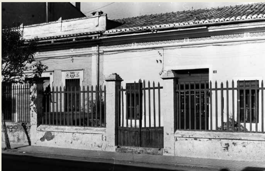
Viviendas de Vicente Lleó, números 18 y 20 actuales, la suya y la de sus padres, en la calle Valencia, frente a la calle Xirivella, hacia 1970. (Archivo Municipal de Torrent).
