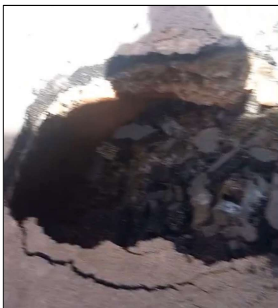
Figura 47. Hundimiento del suelo por el lavado de finos generado tras la inundación.
