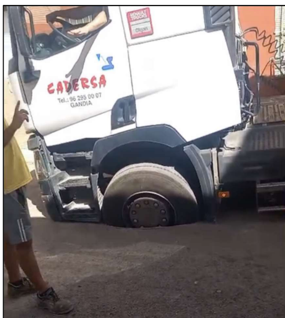
Figura 47. Hundimiento del suelo por el lavado de finos generado tras la inundación.
