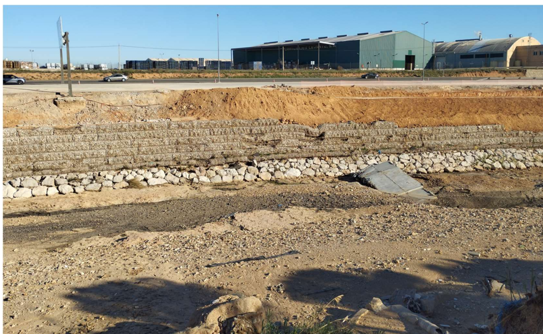
Figura 92. Fotografía B. Muro mixto de gaviones y escollera en el Barranco del Poyo, junto a la CV-36. Se puede apreciar que ha funcionado relativamente bien, a pesar de haber sufrido daños.
