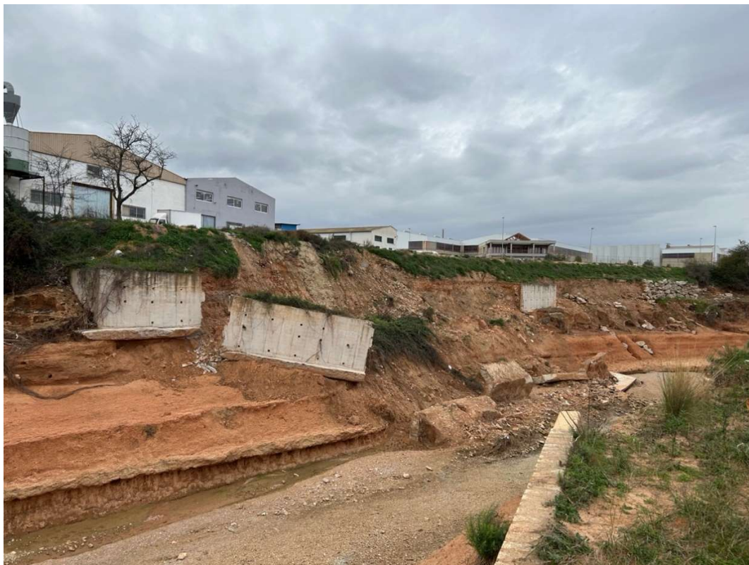
Figura 91. Fotografía A. Desestabilización de muro de hormigón en el Barranco del Poyo, al norte del polígono de Mas del Jutge.
